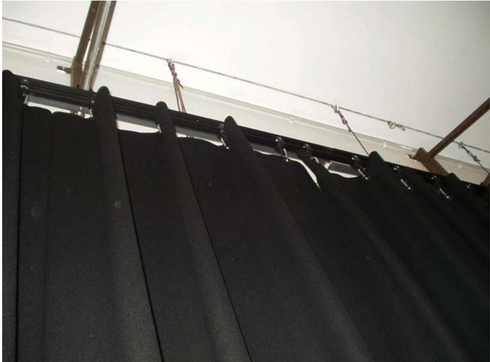
**Abbildung 3.** Detail zum Aufbau mit 100 % Faltenzugabe, exemplarischer Vorhang
