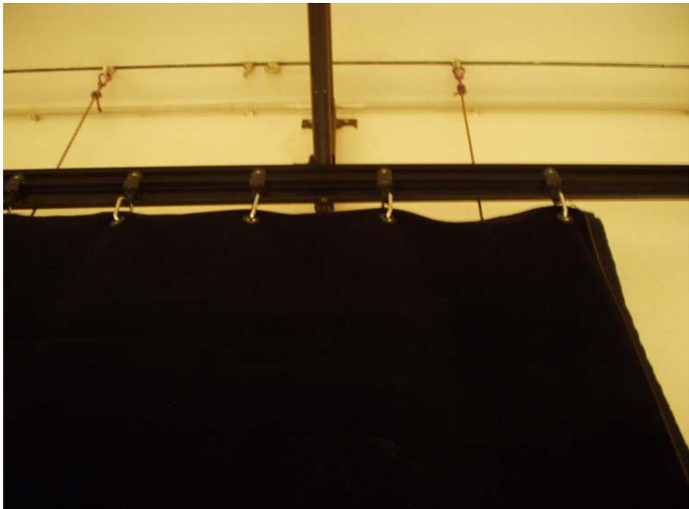
**Abbildung 2.** Detail, Vorgang CLIVIA 600, Aufbau 1 (5 - 10 % Faltenzugabe)
